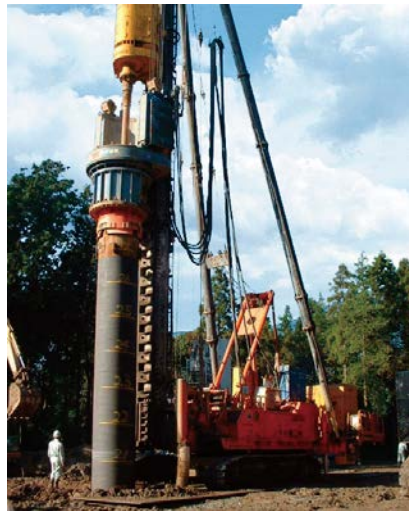
掘削状況(中掘り方式)
