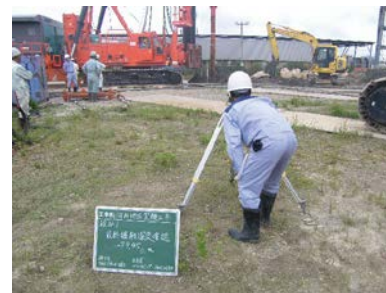
掘削完了(プレボーリング方式)
