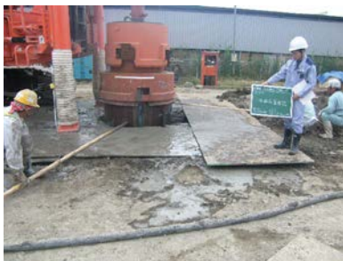
定着状況(プレボーリング方式)
