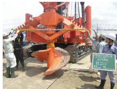
機械式先端ビット (拡翼状態)
