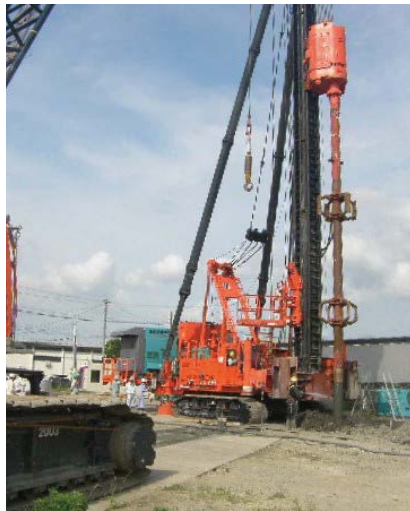
掘削状況(プレボーリング方式)
