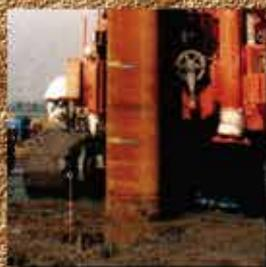
**KING工法**は、機械的に拡翼するKINGビットをスパイラルオーガの先端に取り付け、鋼管杭の管内に挿入して回転させながら、杭先端部の土砂を連続的に排土し、杭を所定の位置まで沈設します。沈設時には排土を助けるために必要に応じて圧縮空気を使用します。その後、KINGビットを杭径D+100~200mmに開いて拡大掘削を行い、杭先端部にセメントミルクを噴出しながら支持層地盤を攪拌混合し、先端拡大根固め球根を築造します。本工法はこのようにして注入された根固め液の硬化によって、杭本体と拡大球根を一体化させ支持力を発現させる工法です。KING工法は、建築・土木両分野で利用できる工法です。建築分野では、(財)日本建築センターおよび(財)ベターリビングの評定を、土木分野では、技術審査証明(平成12年10月)を取得し、杭基礎施工便覧(平成19年1月)に記載されています。
