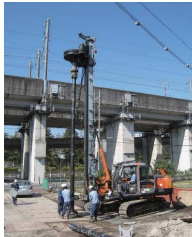
小径杭の施工状況
