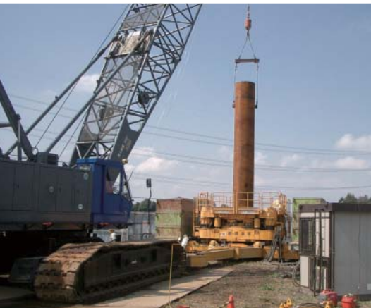
施工状況(全周回転機)
