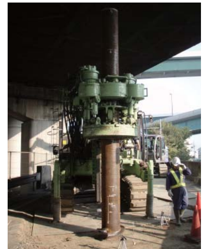
低空頭・狭隘地施工
