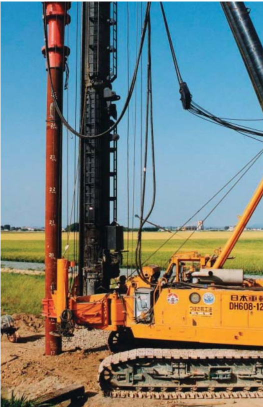
施工状況(クローラ式杭打機)
