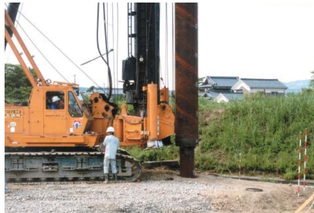
拡頭杭の施工
