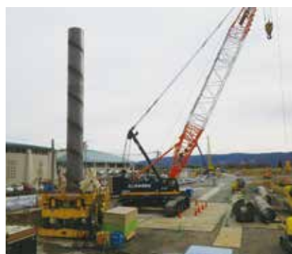
全周回転機による施工
