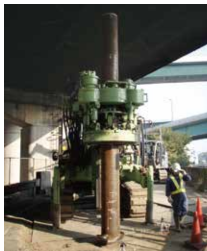
低空頭・狭隘地施工
