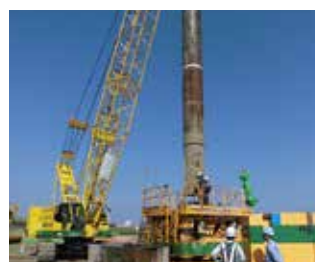
ヤットコ挿入状況
