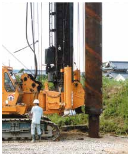
拡頭杭の施工
