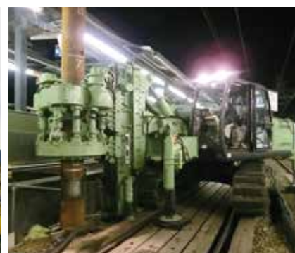
軌道内施工、機械式継手
